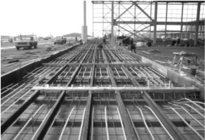
Fig. 3.1 Hangar door SIM construction
